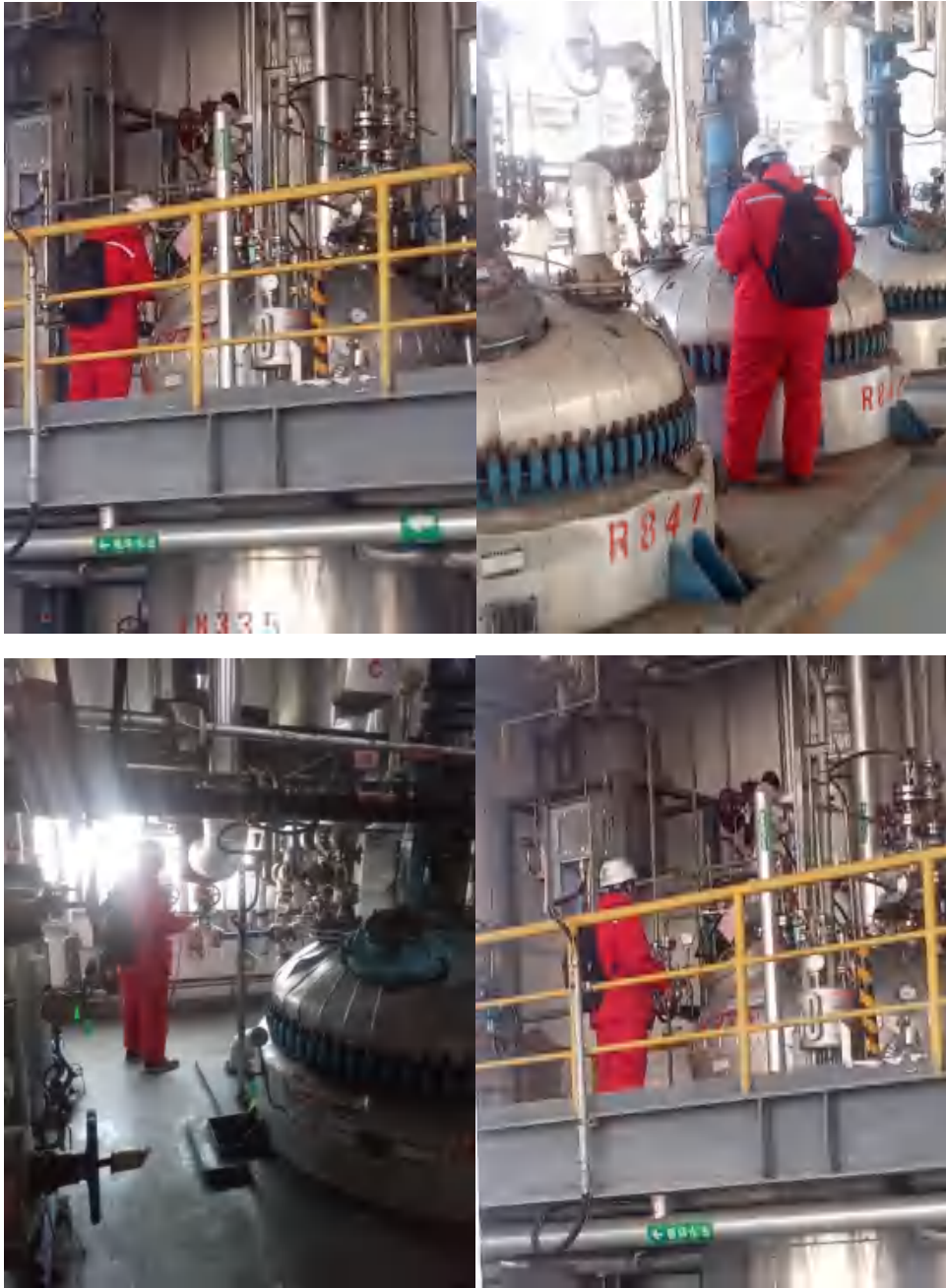
附表 27 现场检测维修照片
